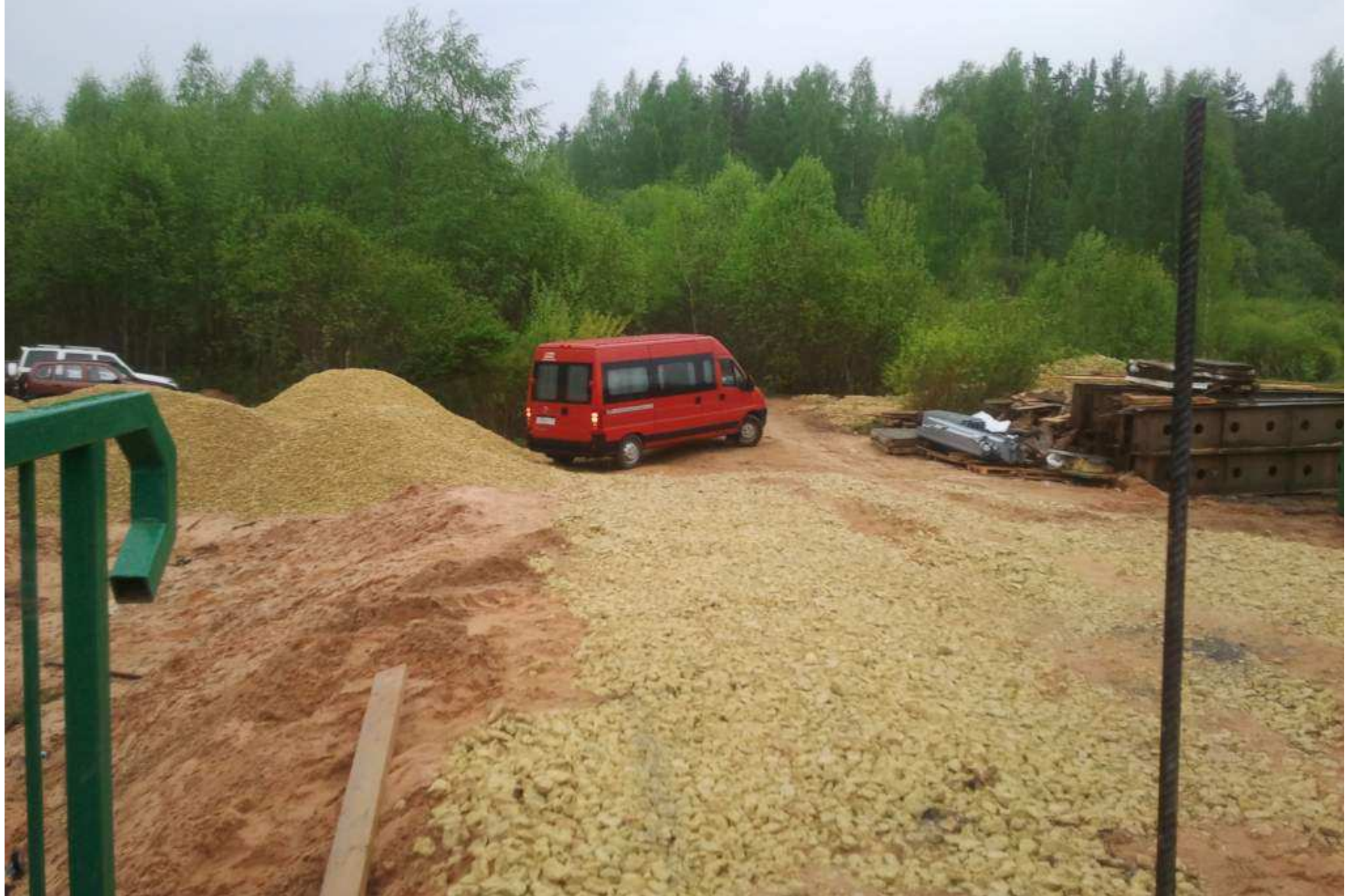
Экспедиционный автобус у реконструируемого моста через р. Ящера в ее нижнем течении
