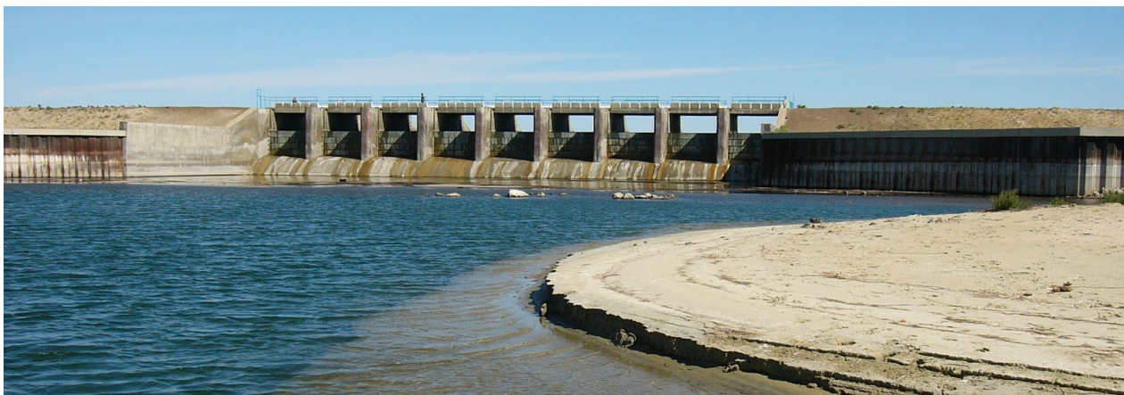
Рисунок 3 – Кок-Аральская земляная плотина с водосборным сооружением, вид с нижнего бьефа (сентябрь 2007 г.). Фото: И. Плотников
