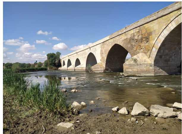
Fig. 2. Kesikköprü Bridge (Kızılırmak River, Kırşehir).
