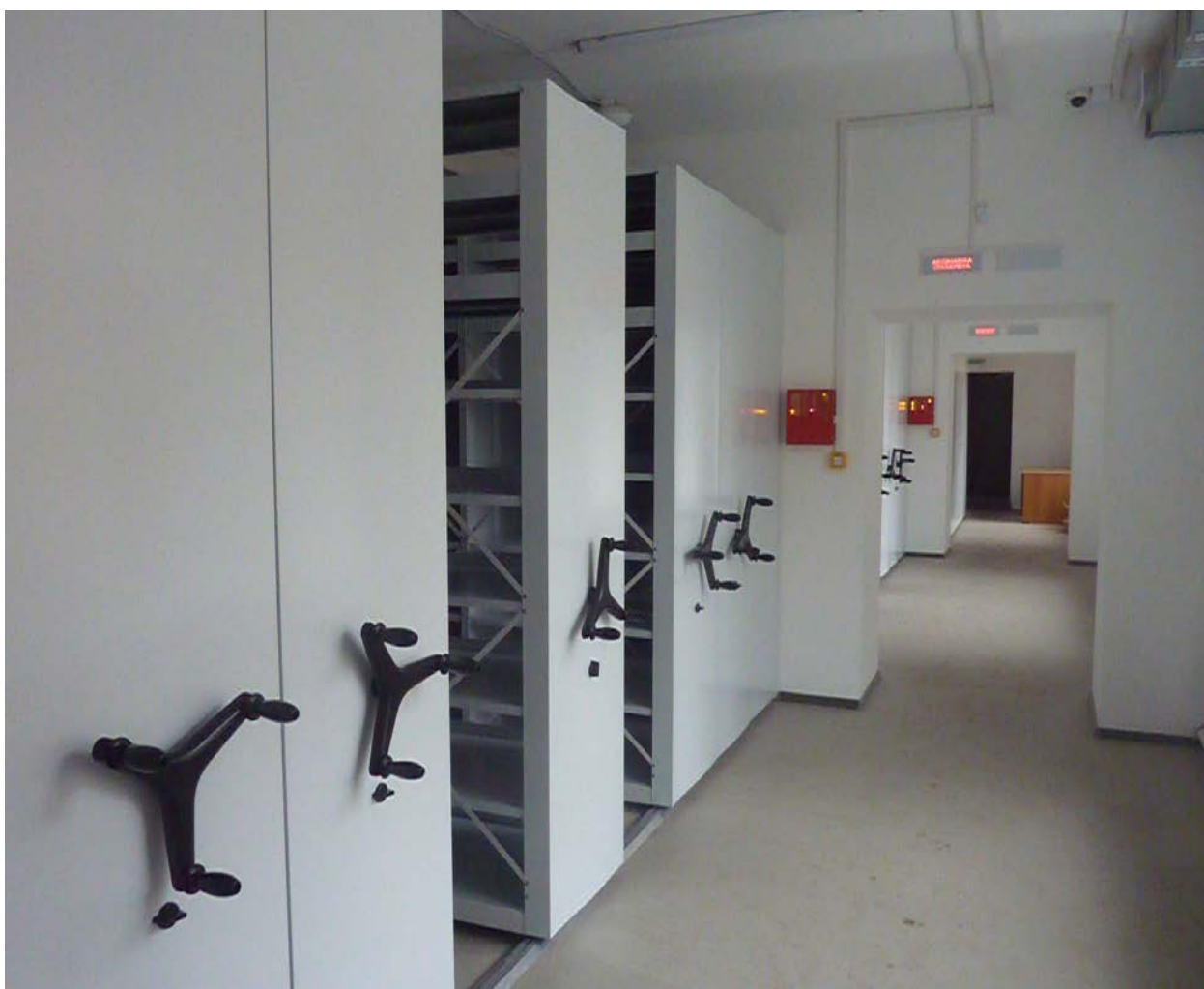
Рисунок 7 – Компакторные системы хранения в коллекционном хранилище «Архив»
