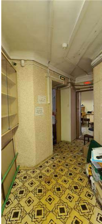
Фото 24. Переход 2 этажа. Пол линолеум. Стены и пол окраска по штукатурки
