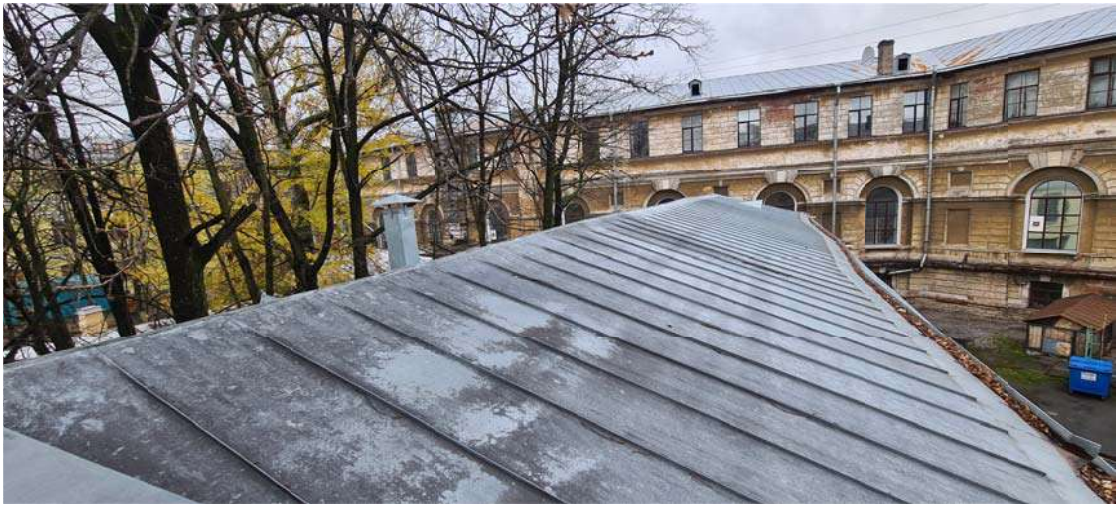
Фото 29. Покрытие кровли оцинкованные листы.
