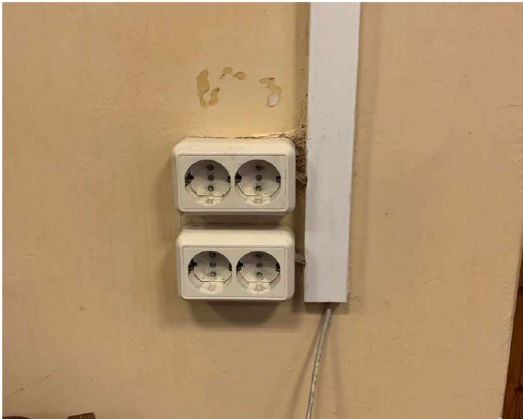
Фото 1.5. Розетки бытовые накладные в кабине второго этажа.
