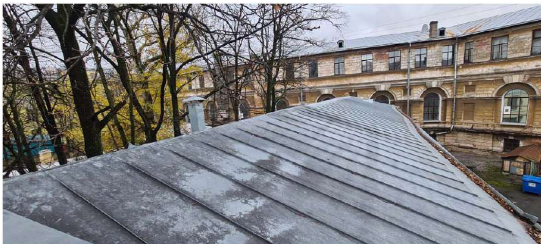
Фото 29. Покрытие кровли оцинкованные листы.
