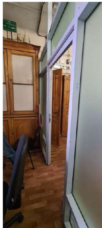
Фото 3. Кабинет со стеклянными перегородками . Пол линолеум ,стены и потолок штукатурка с окраской
