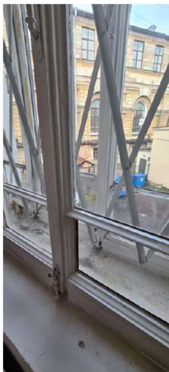
Фото 20. Помещение архива. Оконный блок
