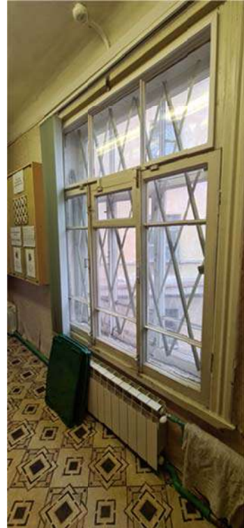
Фото 26. Переход 2 этажа. Оконный проем.
