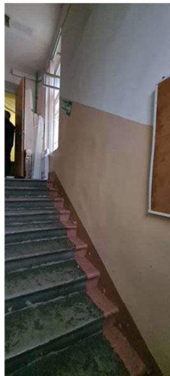
Фото 14. Лестница .Общий вид . Стены штукатурка с покраской.
