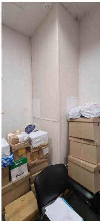
Фото 15. Кабинет. Отделка стен ПВХ панелями..
