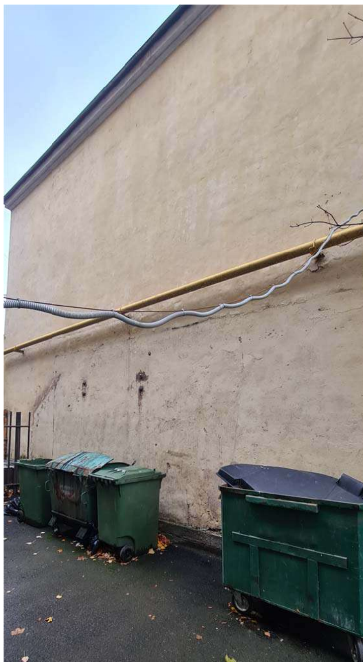
Фото №1.в. Боковой фасад.
