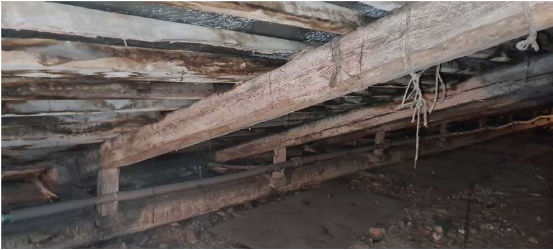
Фото 28. Стропильная нога. Повреждение грибком обрешетки.
