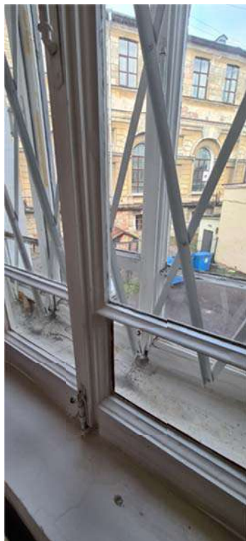
Фото 20. Помещение архива. Оконный блок
