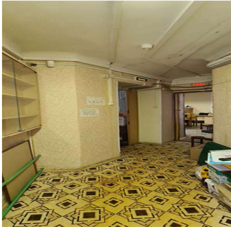
Фото 1.7. Отсутствует ручной пожарный извещатель. Должен размещаться на стене рядом с эвакуационным выходом на высоте 1,5м от пола
