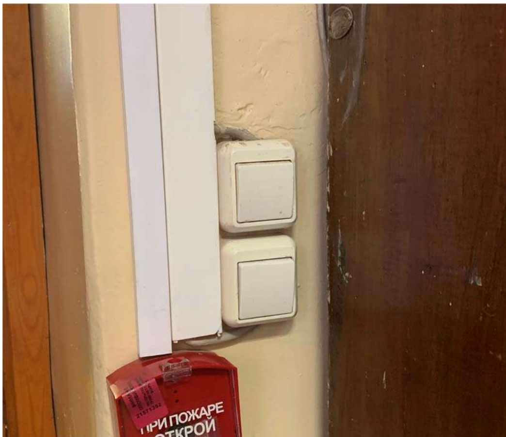
Фото 1.4. Выключатель освещения накладной в кабинете второго этажа.
