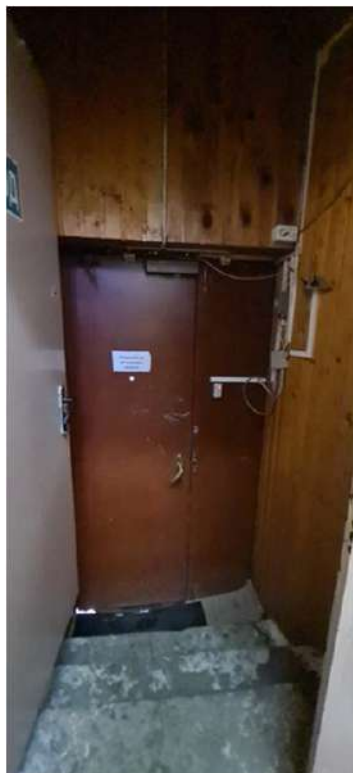
Фото 1. Входной тамбур. Обшивка стен деревянной вагонкой .
