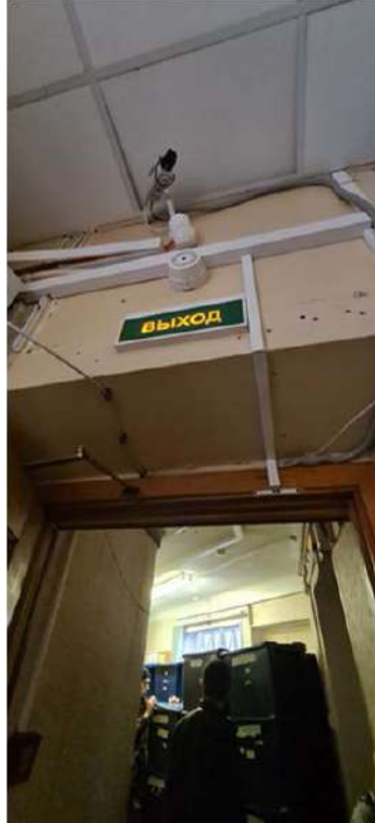
Фото 1.9. Дымовой пожарной извещатель должен размещаться на потолке.
