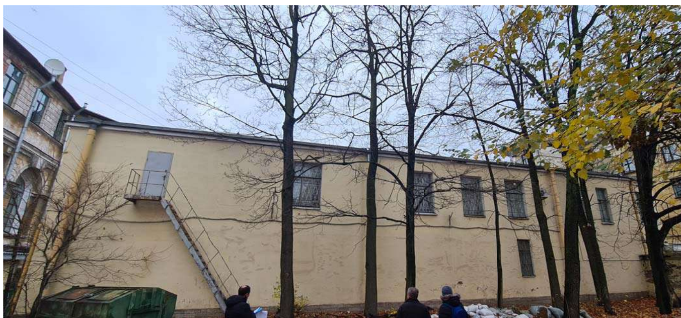
Фото № 1.б. Вид дворового фасада здания.
