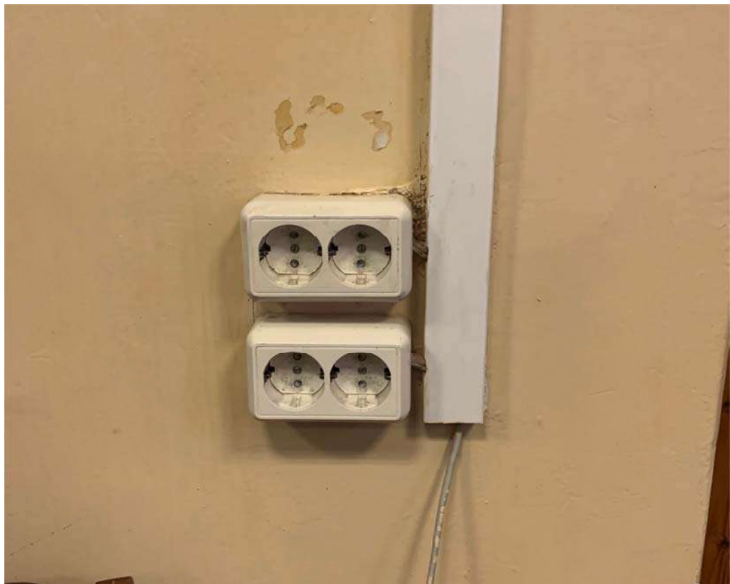
Фото 1.5. Розетки бытовые накладные в кабине второго этажа.
