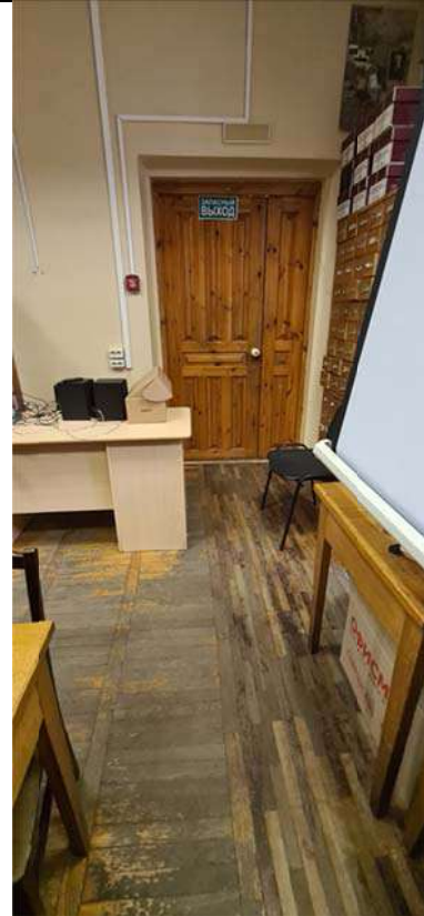
Фото 4. Кабинет . Пол паркет (70% истертости) ,стены и потолок окраска по штукатурки
