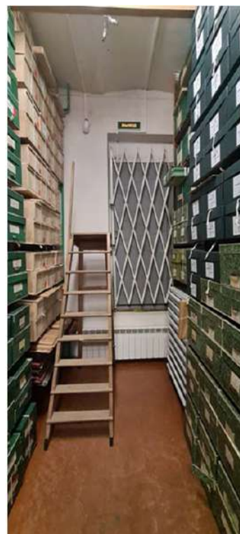
Фото 22. Помещение архива. Бетонный крашенный пол. Стены и потолок окраска по штукатурки
