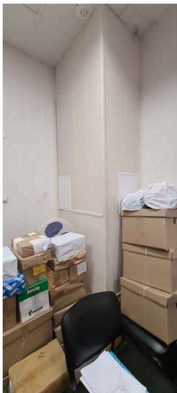
Фото 15. Кабинет. Отделка стен ПВХ панелями..
