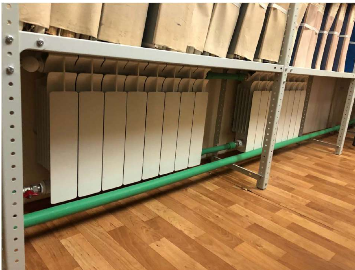
Фото 1.1. Установка отопительного прибора.
