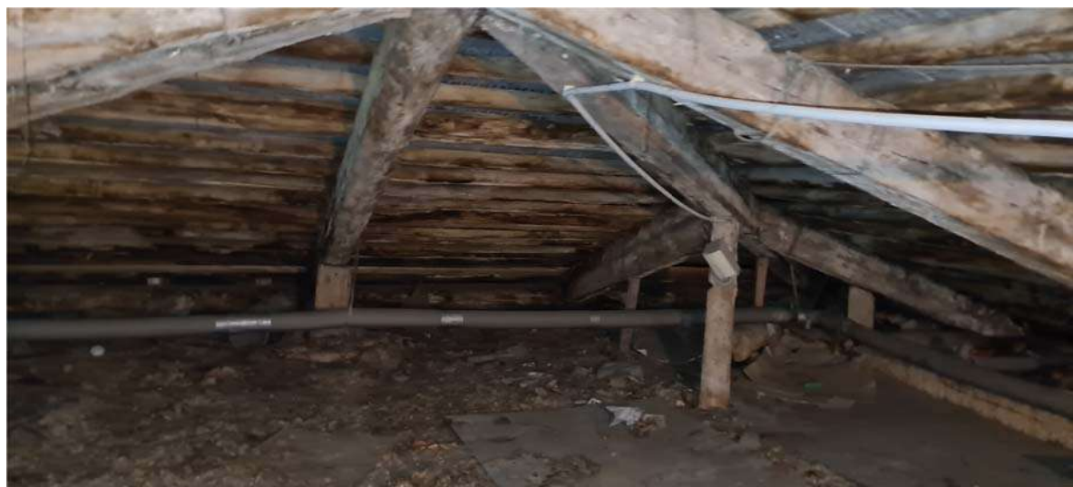
Фото 27. Стропильная система. Повреждение грибком стропильных ног.
