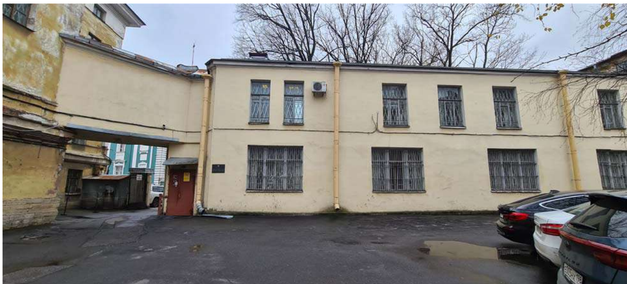
Фото №1.г. Главный фасад , вид на переход .
