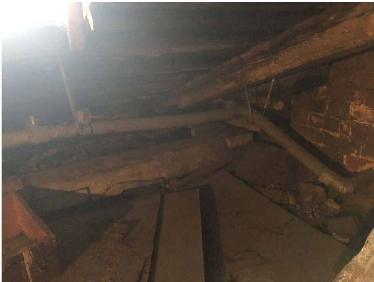
Фото 1.4. Трубопроводы системы отопления на чердаке.
