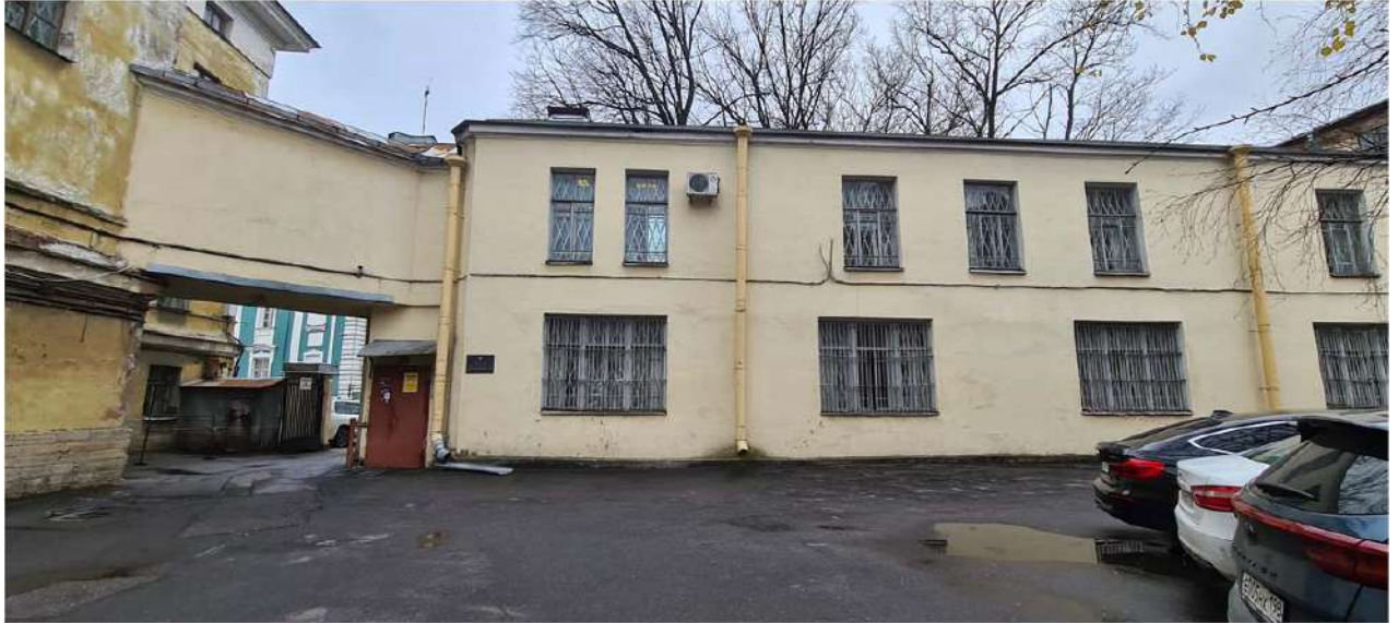
Фото №1.г. Главный фасад , вид на переход .
