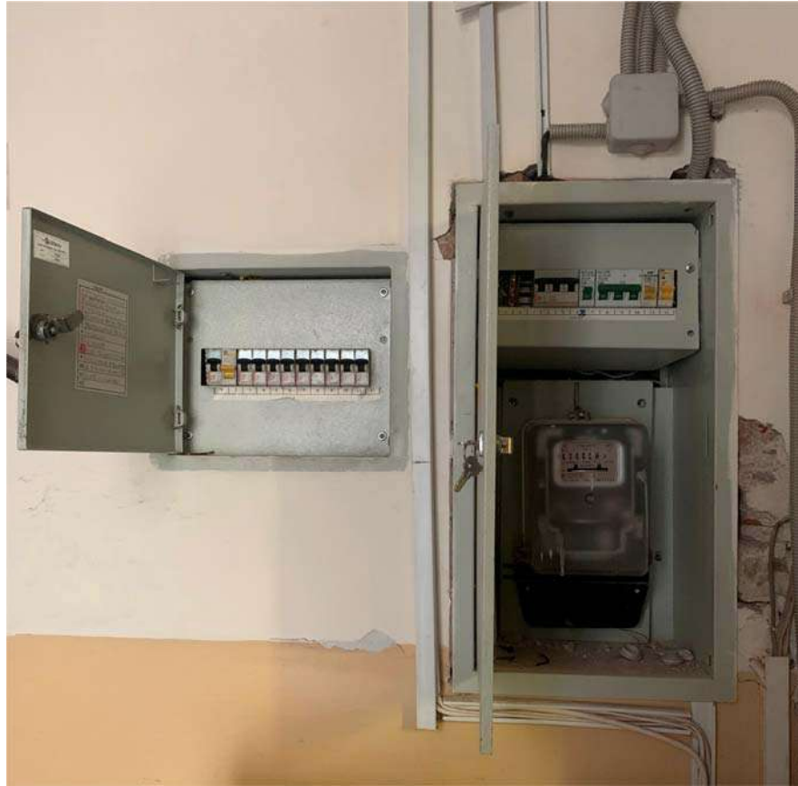
Фото 1.1. Вводно- распределительного щит ГРП на лестничной клетке.
