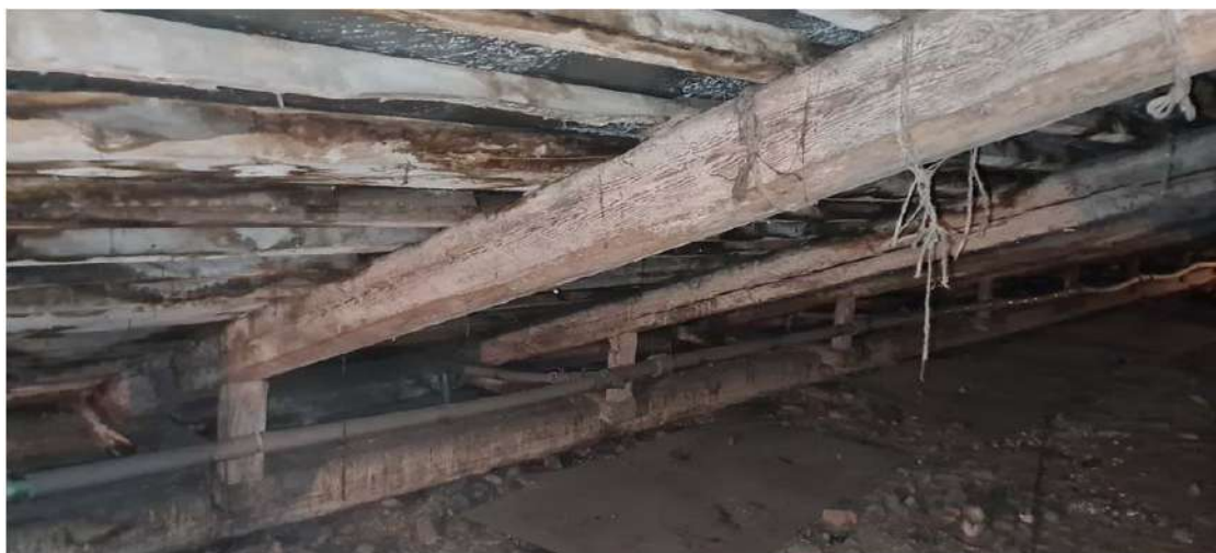
Фото 28. Стропильная нога. Повреждение грибком обрешетки.
