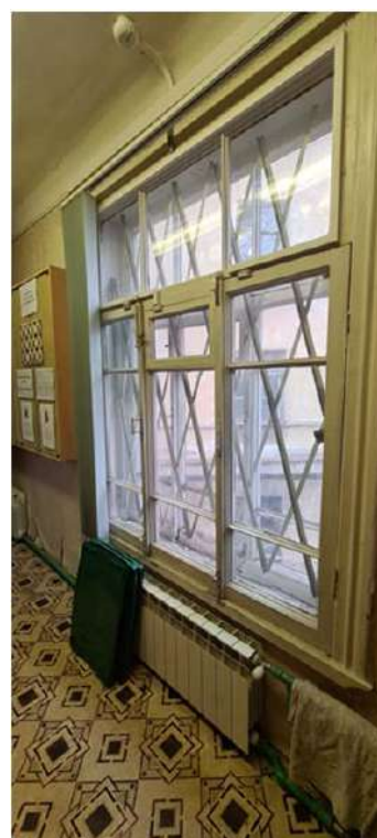
Фото 26. Переход 2 этажа. Оконный проем.
