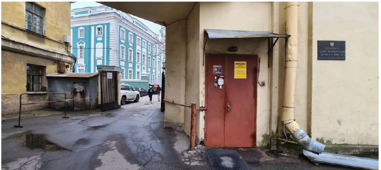
Фото №1.д. Главный вход в здание.
