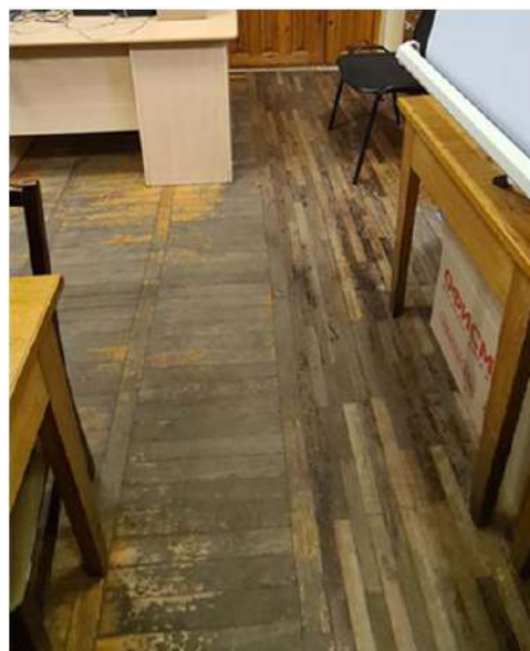
Фото 7 . Кабинет . Паркет в неудовлетворительном состоянии
