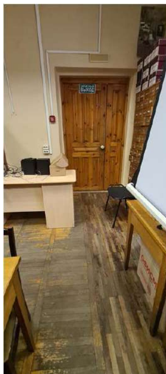
Фото 4. Кабинет . Пол паркет (70% истертости) ,стены и потолок окраска по штукатурки
