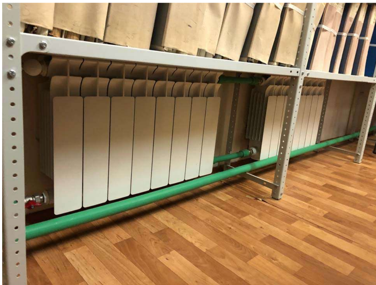
Фото 1.1. Установка отопительного прибора.
