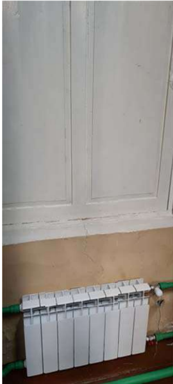
Фото 10. Помещение архива .Радиатор отопления ,оконный проем.
