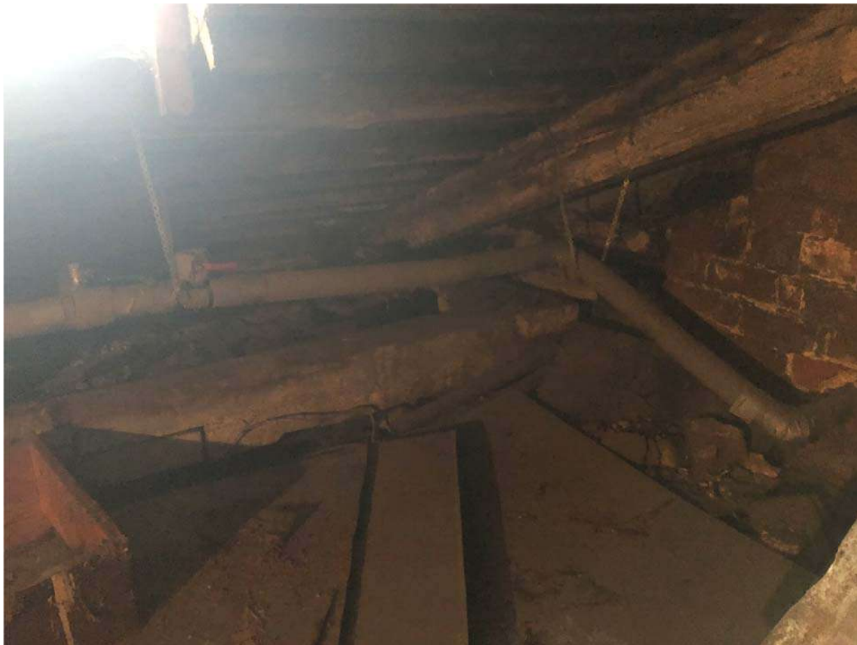
Фото 1.4. Трубопроводы системы отопления на чердаке.
