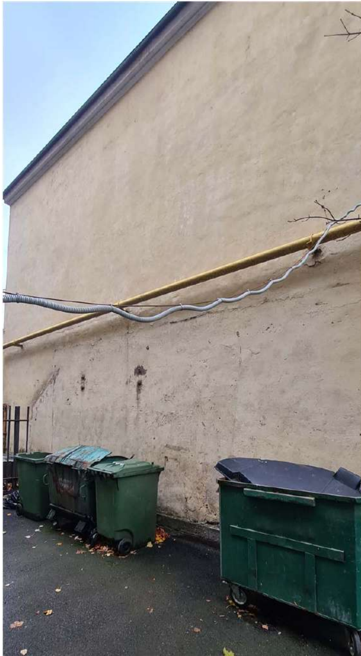
Фото №1.в. Боковой фасад.
