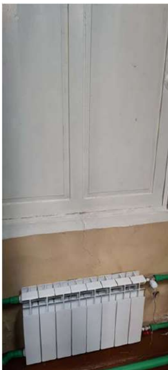
Фото 10. Помещение архива .Радиатор отопления ,оконный проем.
