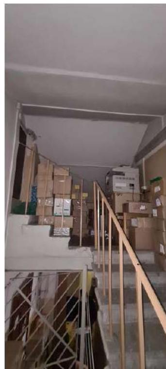
Фото 25. Лестница на чердак
