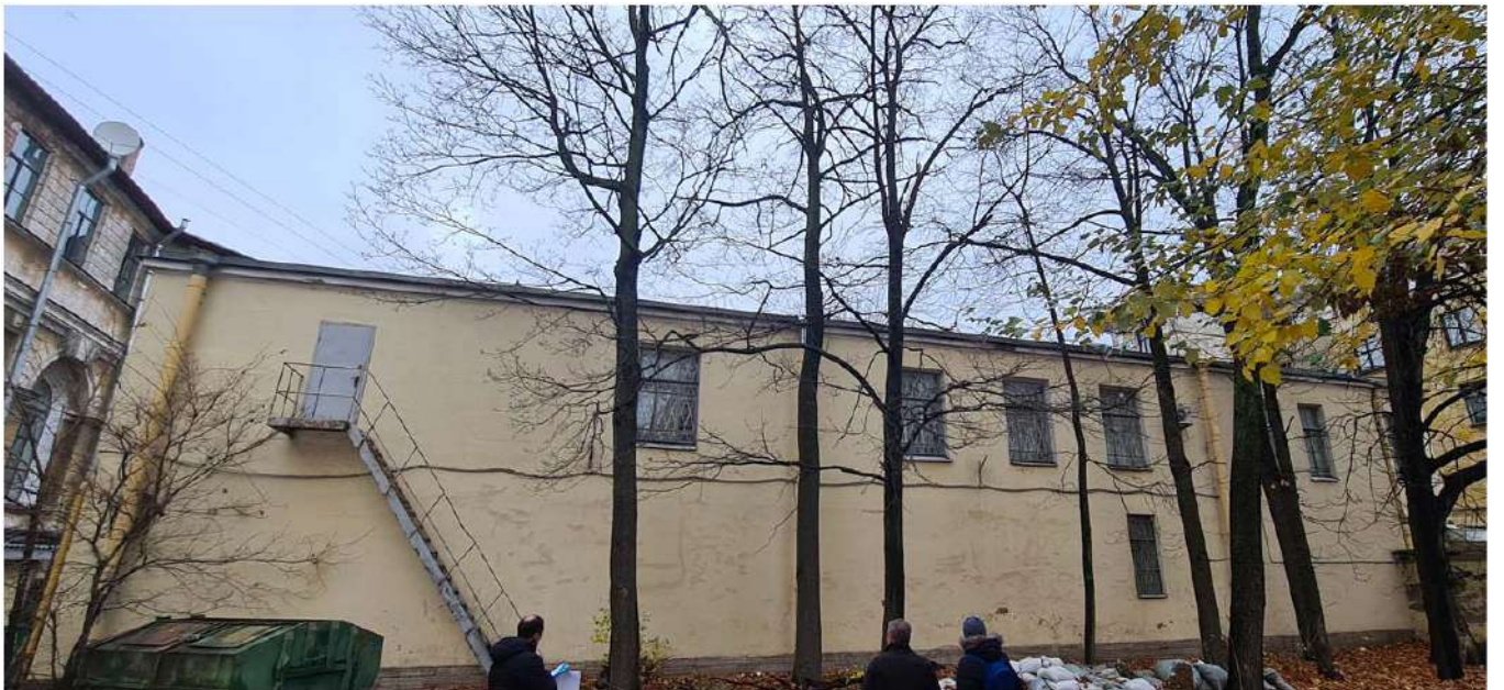
Фото № 1.б. Вид дворового фасада здания.
