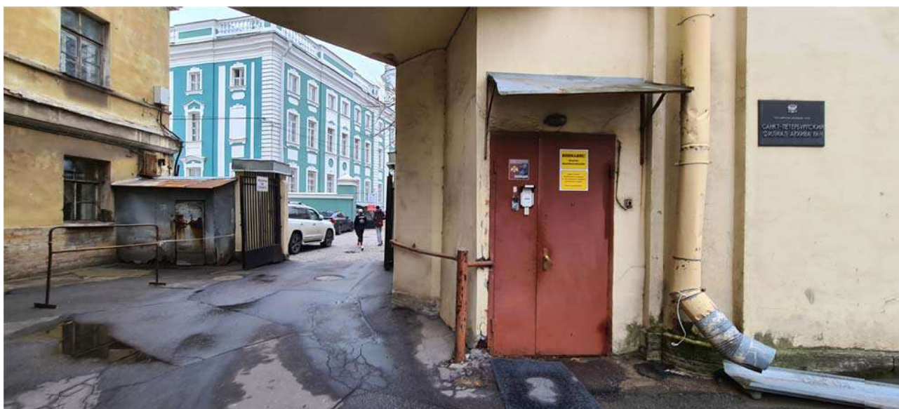
Фото №1.д. Главный вход в здание.
