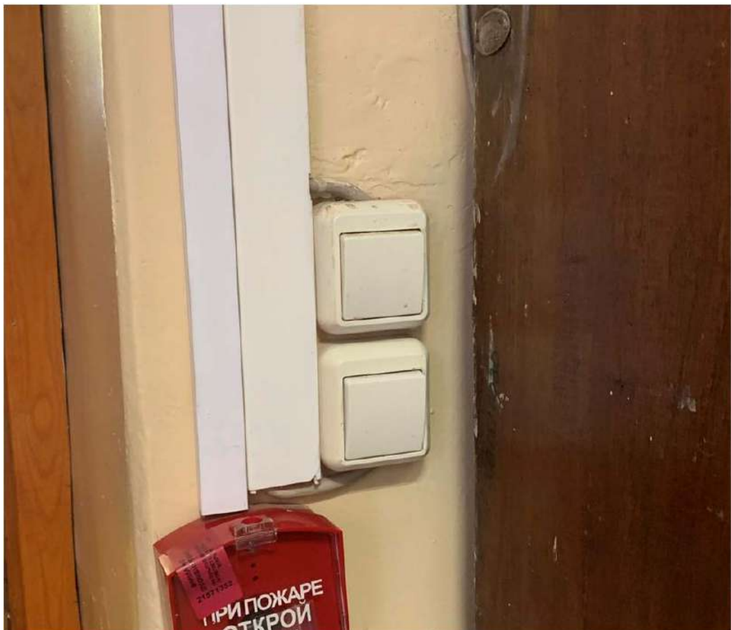
Фото 1.4. Выключатель освещения накладной в кабинете второго этажа.
