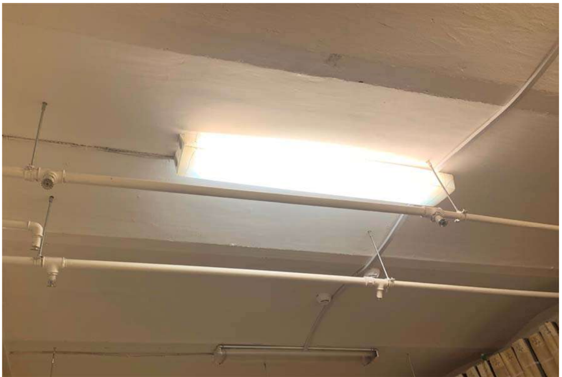
Фото 1.3. Светильник потолочный накладной в фондохранилище второго этажа.
