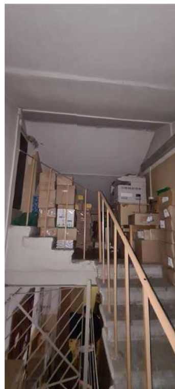
Фото 25. Лестница на чердак
