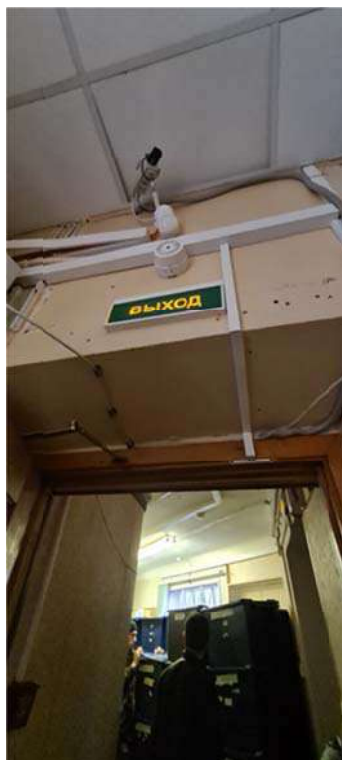
Фото 1.9. Дымовой пожарный извещатель должен размещаться на потолке.
