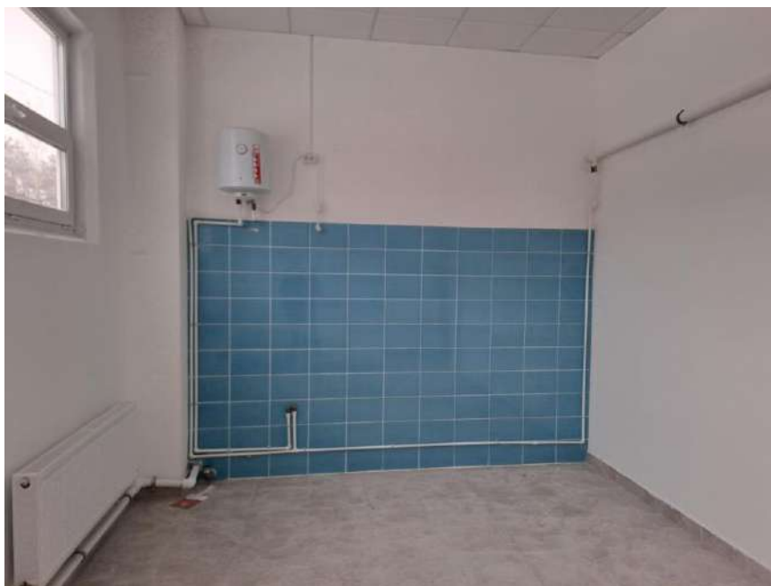
Рисунок 12 – Отремонтированное лабораторное помещение, оборудование еще не установлено. Лабораторно-коллекционный комплекс «Шувалово»
