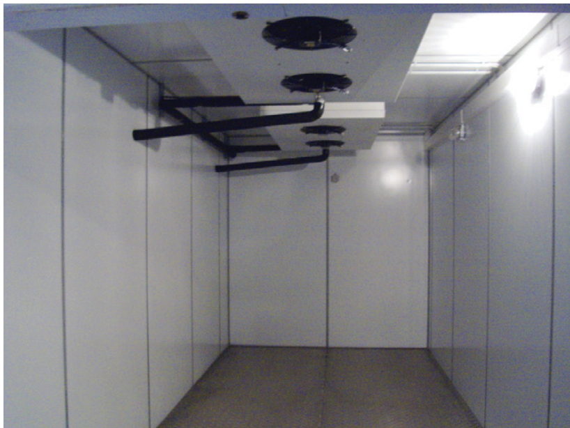
Рис. 2. Внутренний объем низкотемпературной камеры (фото 2010 г.)
