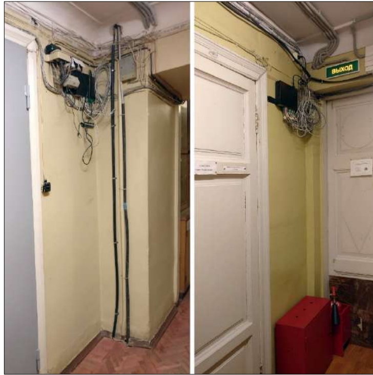
Рисунок 11 – Состояние магистральных узлов корпоративной сети до модернизации
