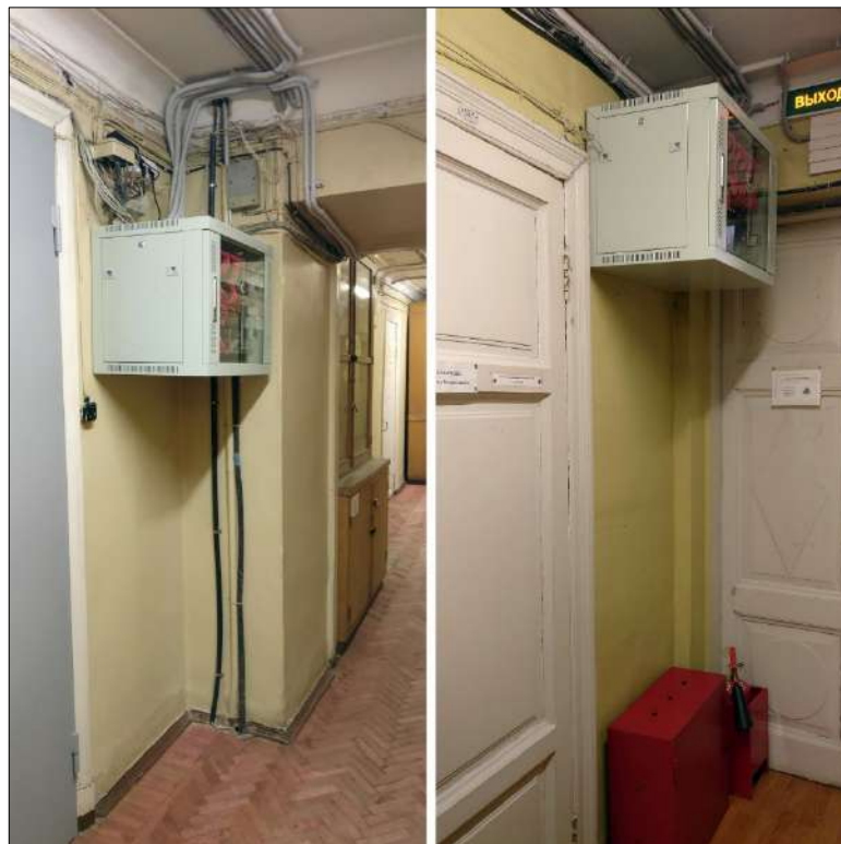
Рисунок 11 – Состояние магистральных узлов корпоративной сети до модернизации
