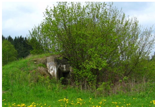
Obr. 3. Lokalita Tuškov, bunkr 14 – typické umístění bunkru vzor 37 v terénním pahrbku. Foto: V. Vlk.
