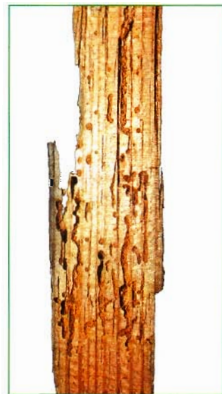
Рис. 4. Точильщик мебельный — Anobium punctatum , внутреннее повреждение древесины (ориг.).
